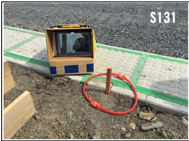
IMG_1892 撮影日:平成30年6月14日
