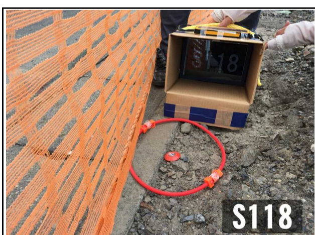
IMG_1988 撮影日：平成30年6月14日
