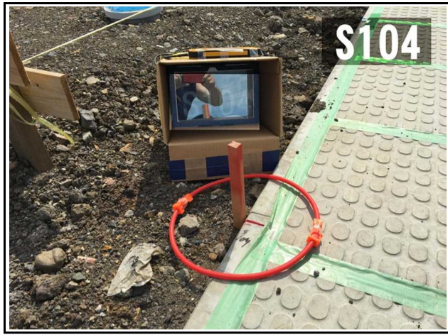
IMG_1920 撮影日：平成30年6月14日
