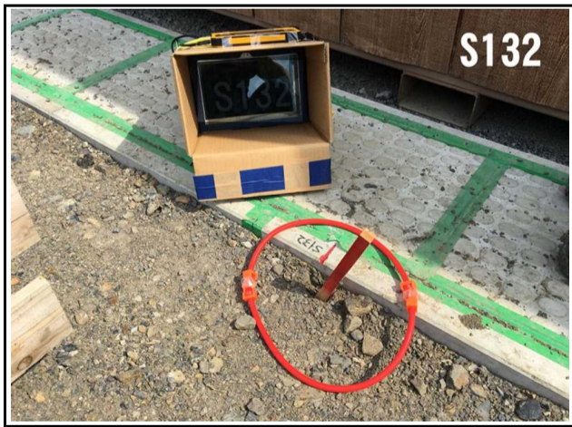
IMG_1890 撮影日:平成30年6月14日
