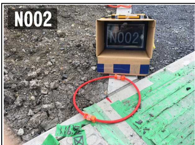
IMG_1962 撮影日：平成30年6月14日
