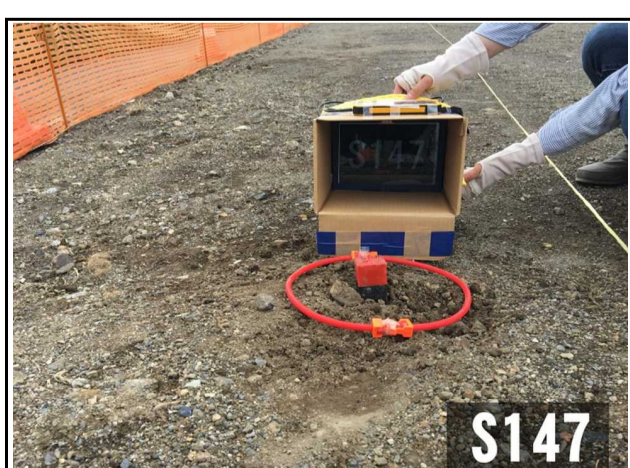
IMG_1991 撮影日：平成30年6月14日
