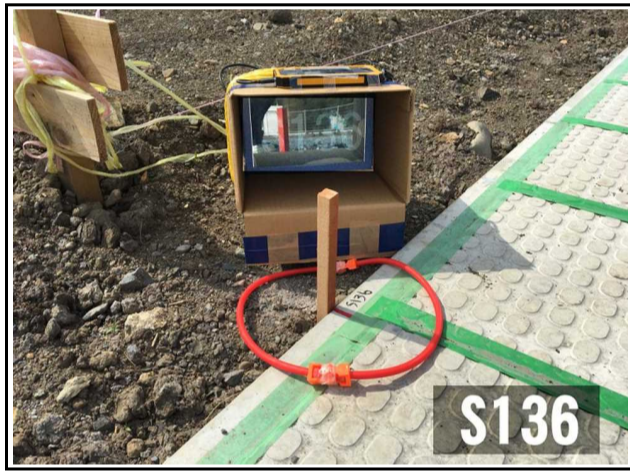
IMG_1924 撮影日：平成30年6月14日
