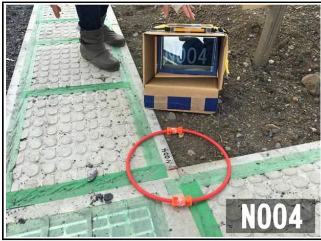
IMG_1956 撮影日：平成30年6月14日
