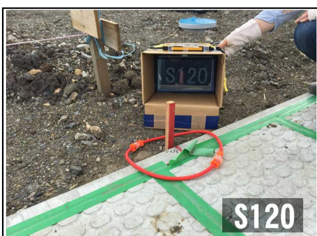
IMG_1964 撮影日：平成30年6月14日
