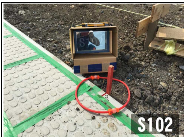
IMG_1948 撮影日:平成30年6月14日
