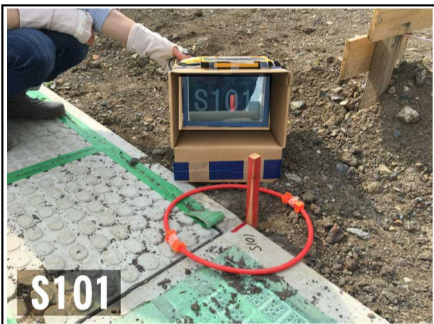
IMG_1949 撮影日:平成30年6月14日
