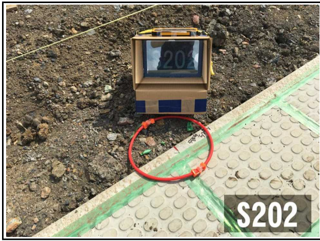
IMG_1919 撮影日：平成30年6月14日
