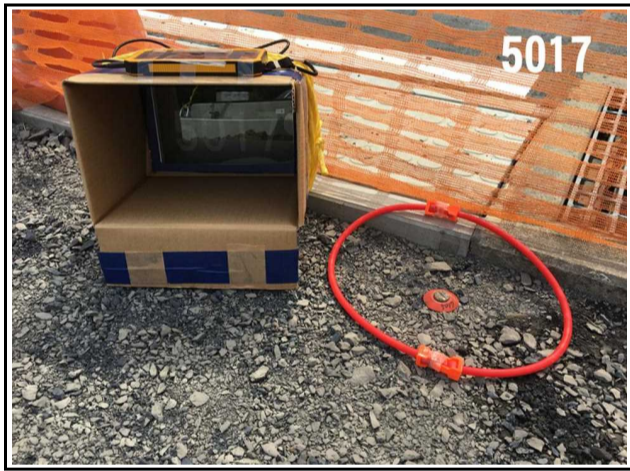
IMG_1888 撮影日:平成30年6月14日
