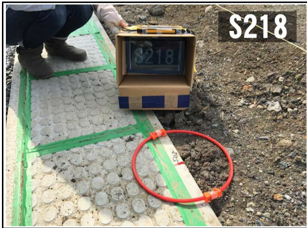
IMG_1946 撮影日:平成30年6月14日
