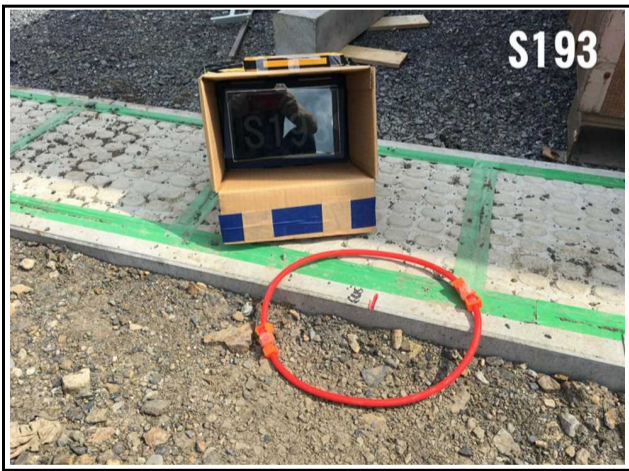
IMG_1891 撮影日:平成30年6月14日
