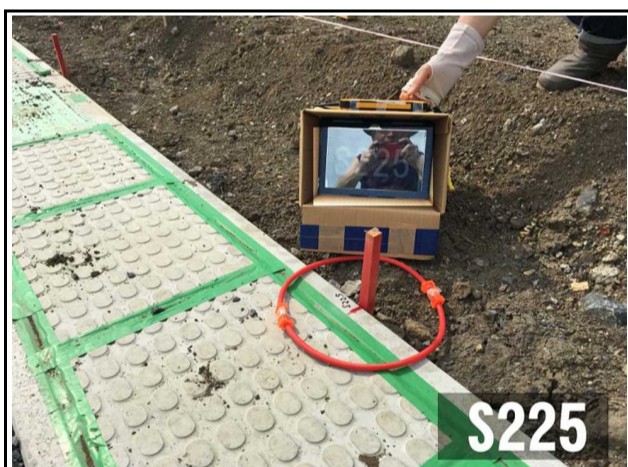
IMG_1950 撮影日:平成30年6月14日
