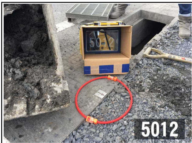
IMG_1960 撮影日：平成30年6月14日
