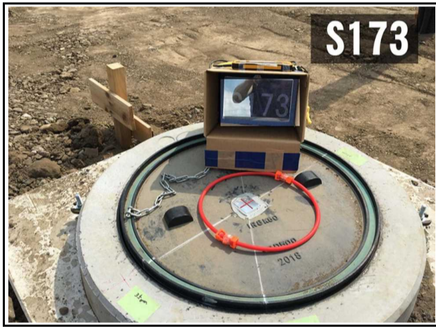
IMG_1925 撮影日：平成30年6月14日
