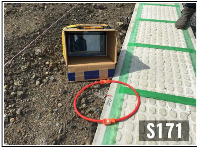
IMG_1922 撮影日：平成30年6月14日
