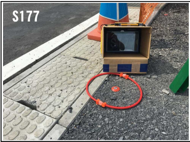
IMG_1889 撮影日:平成30年6月14日
