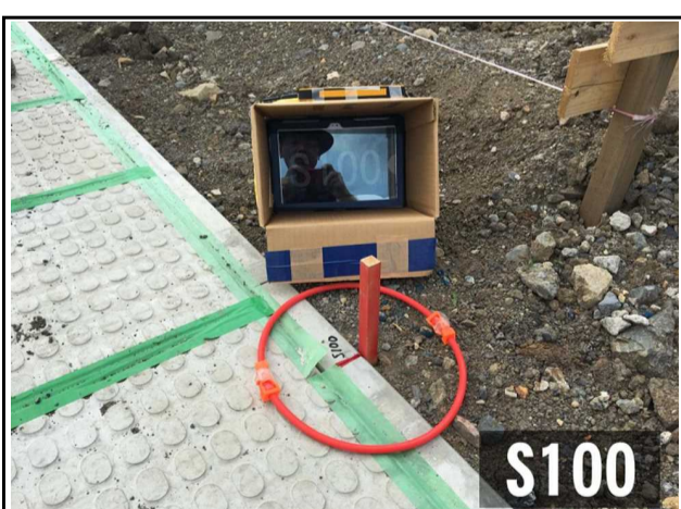
IMG_1953 撮影日:平成30年6月14日
