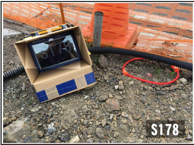
IMG_1887 撮影日:平成30年6月14日
