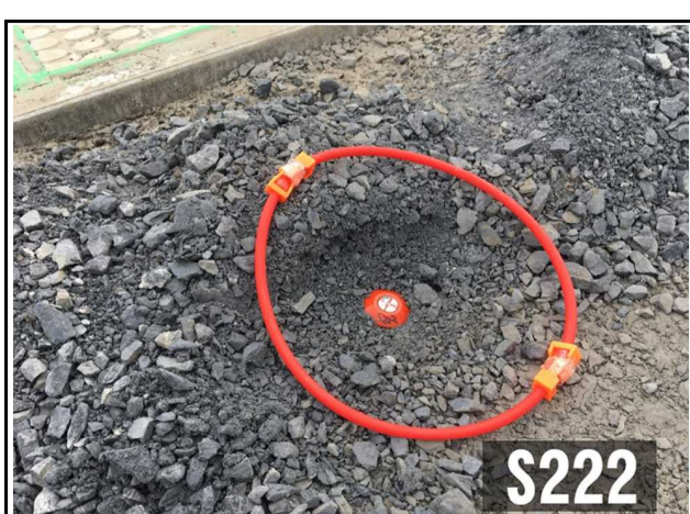
IMG_1966 撮影日：平成30年6月14日
